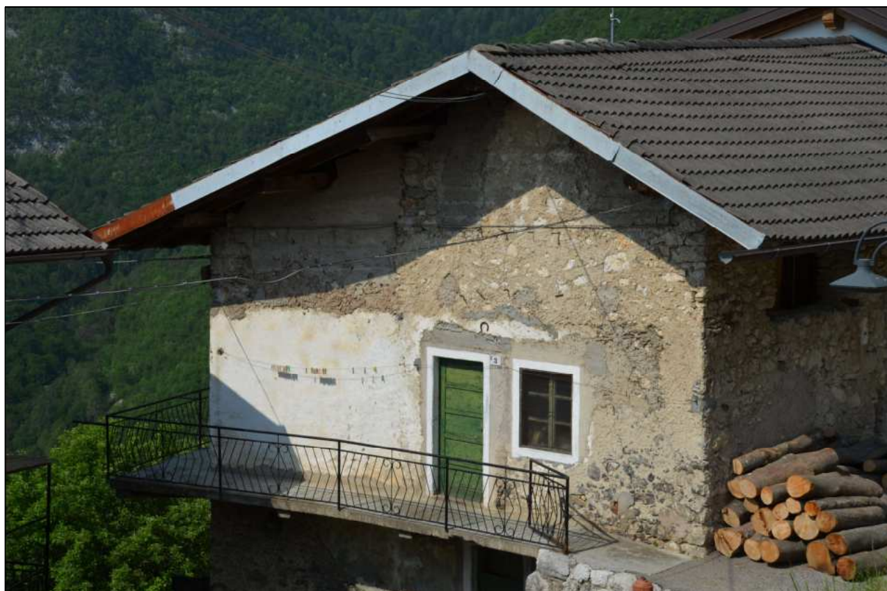
COPERTURE DI TEGOLE IN CEMENTO COLORE GRIGIO
