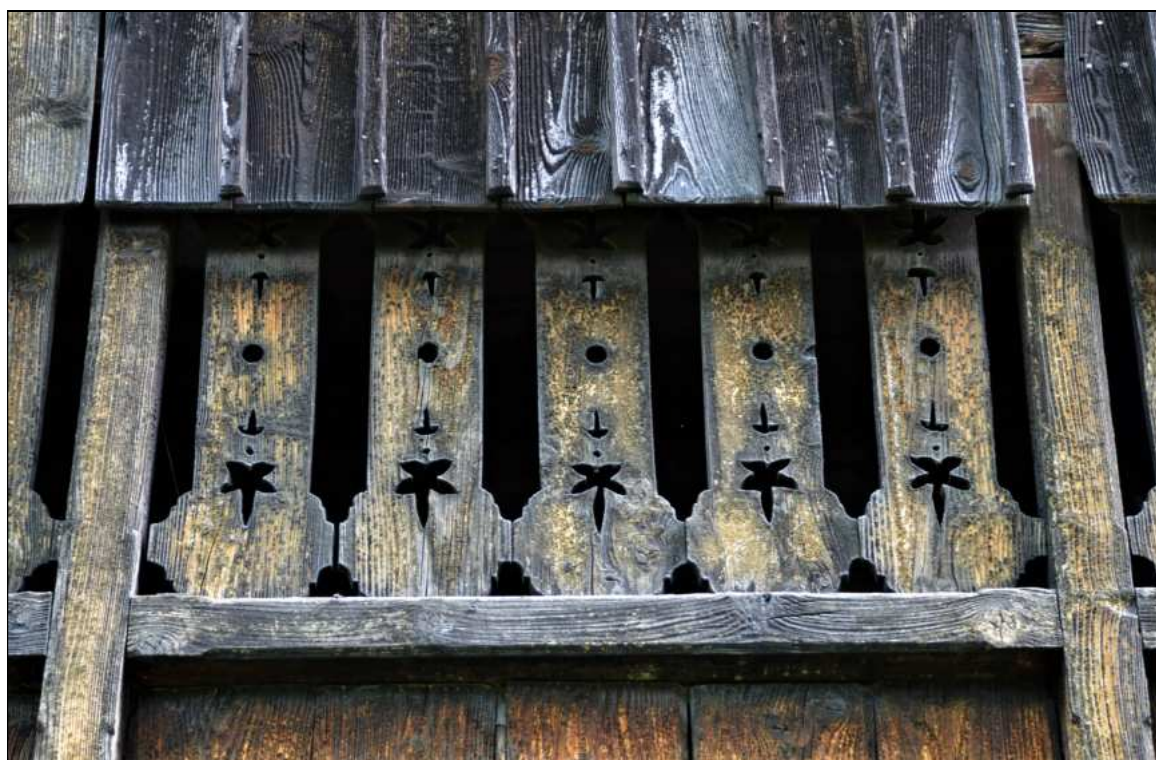
POGGIOLI CON PARAPETTI IN LEGNO A FILETTI O TAVOLE VERTICALI
