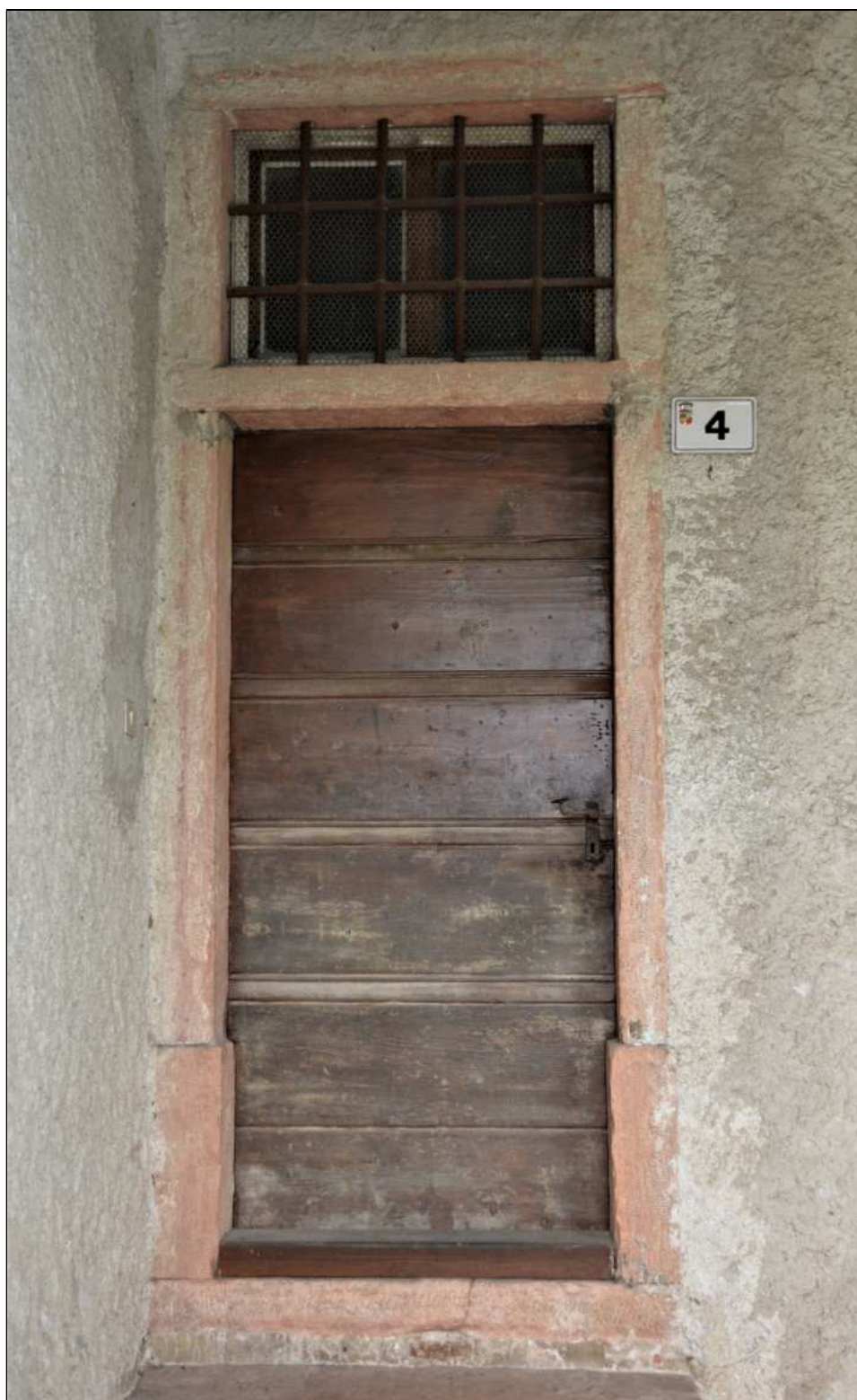
CONTORNI IN PIETRA E SOPRALUCE CON INFERRIATE
