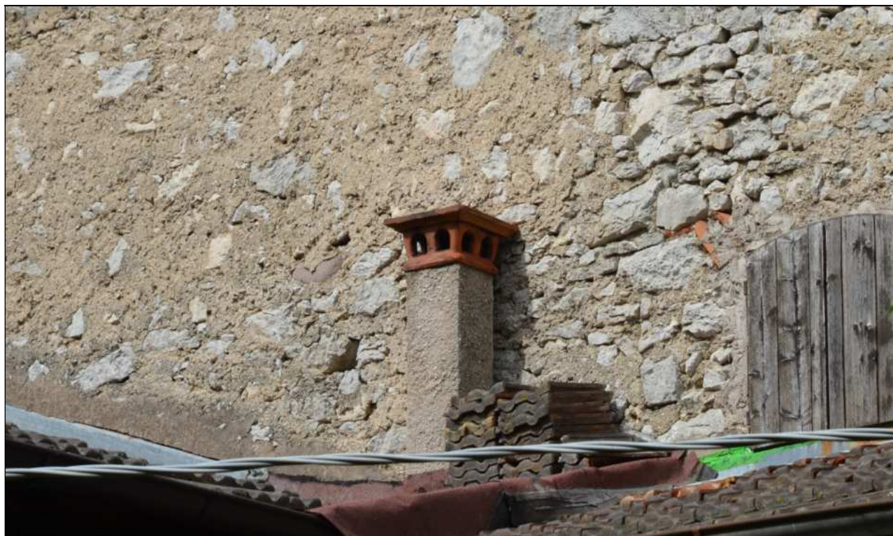
TORRETTE INTONACATE CON CAPPELLI IN LATERIZIO
