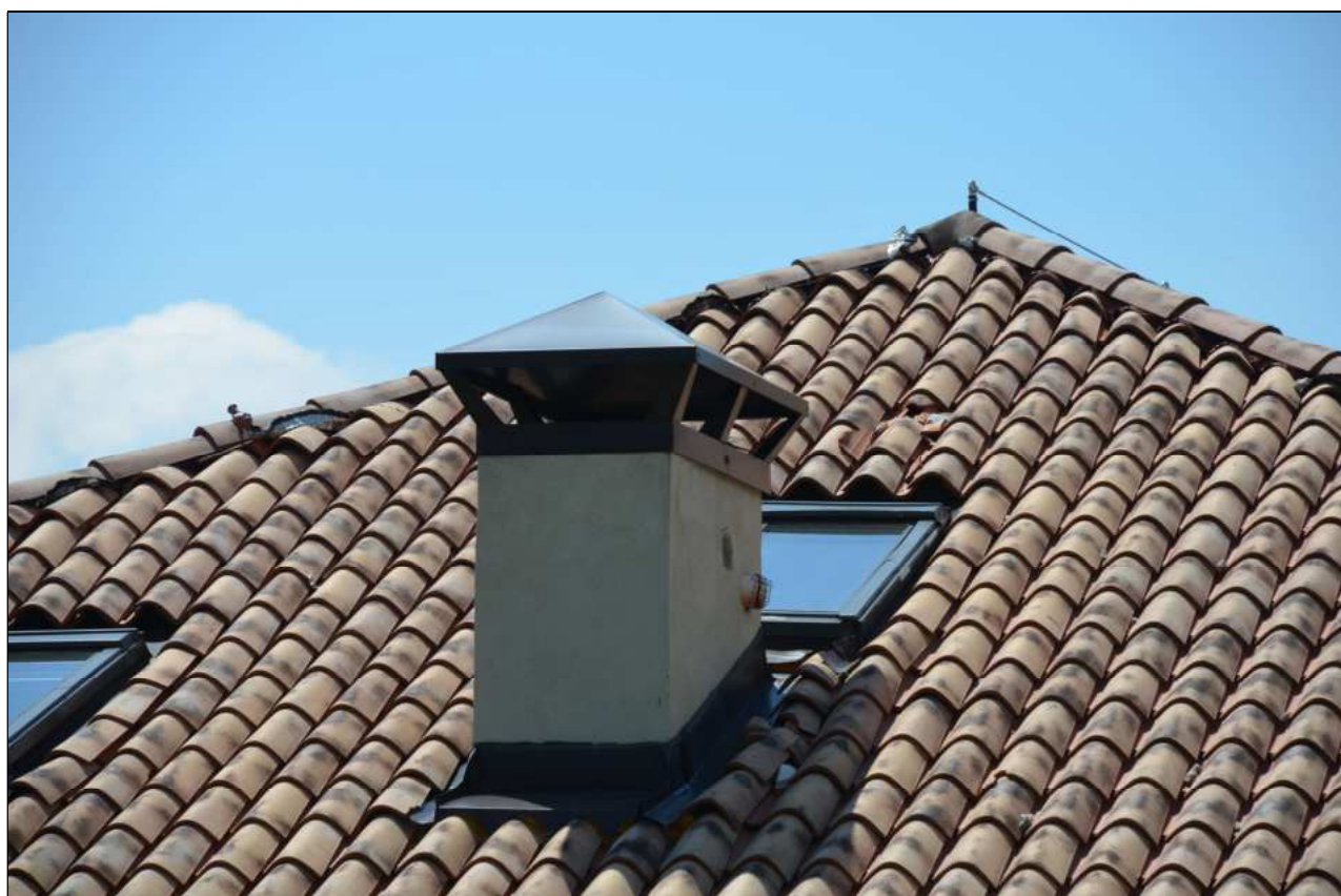
TORRETTE INTONACATE CON CAPPELLI IN LAMIERA
