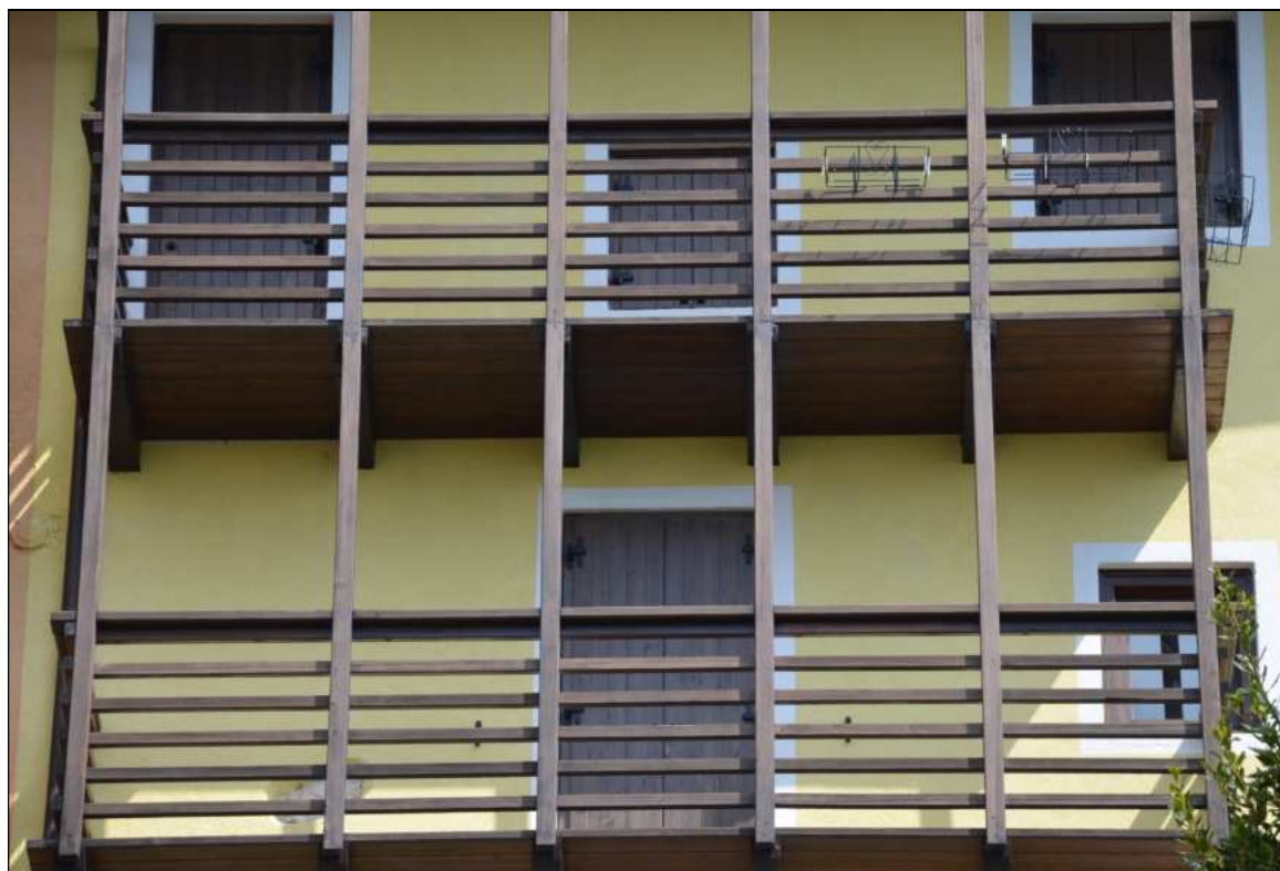
POGGIOLI E BALLATOI CON PARAPETTI IN LEGNO A FILETTI O TAVOLE ORIZZONTALI
