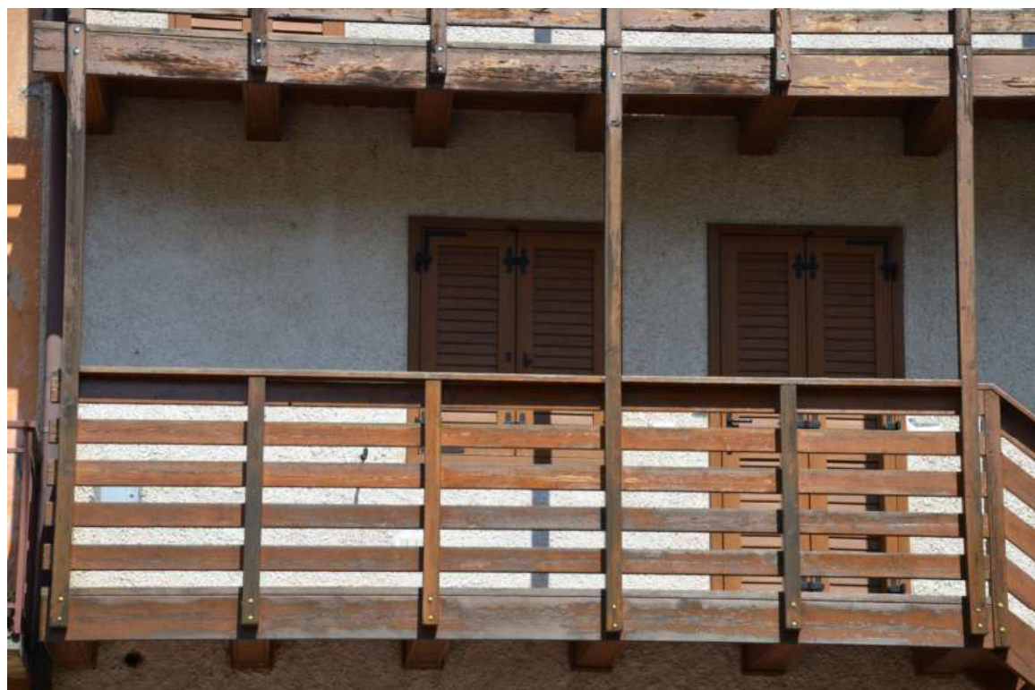
POGGIOLI E BALLATOI CON PARAPETTI IN LEGNO A FILETTI O TAVOLE ORIZZONTALI
