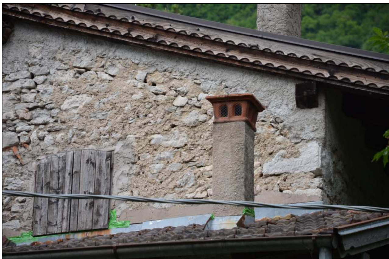
TORRETTE INTONACATE CON CAPPELLI IN LATERIZIO
