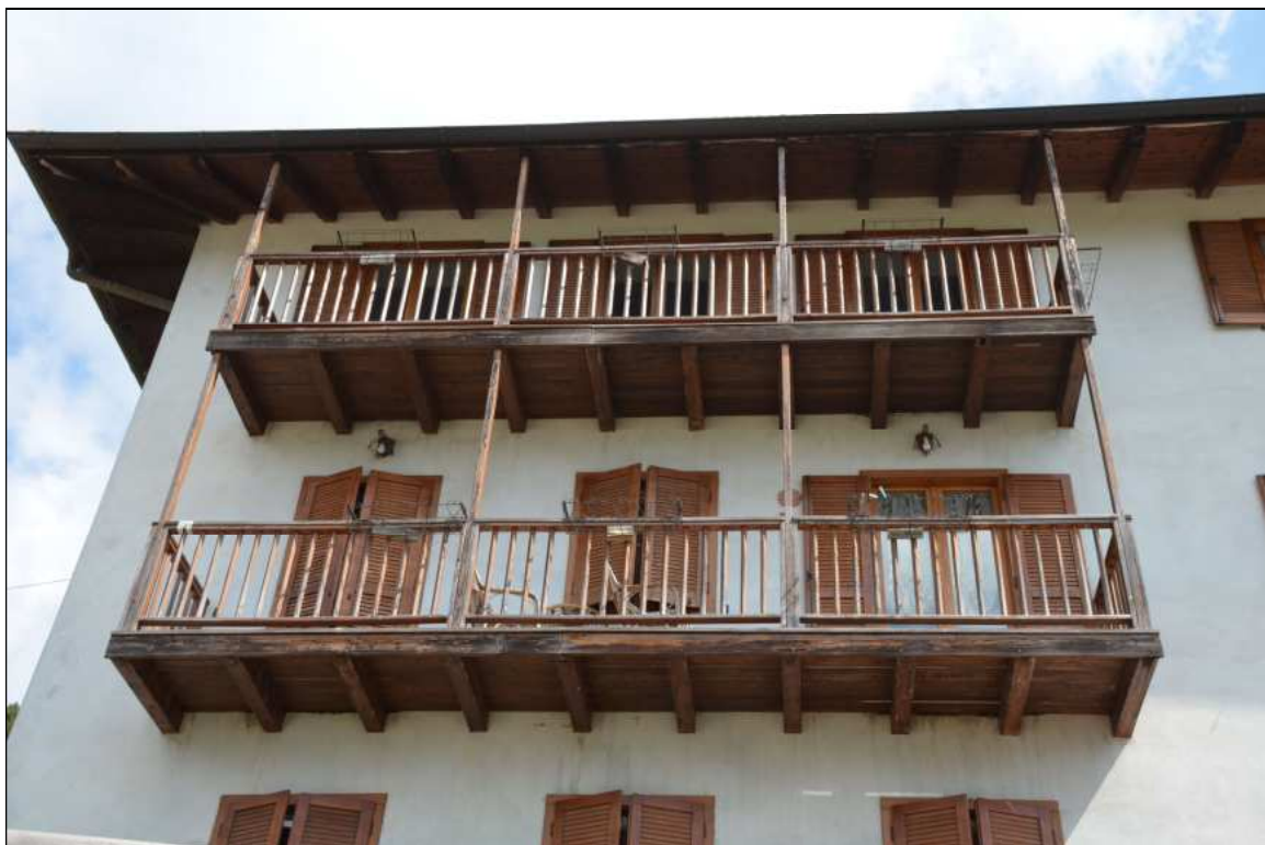
POGGIOLI CON PARAPETTI IN LEGNO A FILETTI VERTICALI
