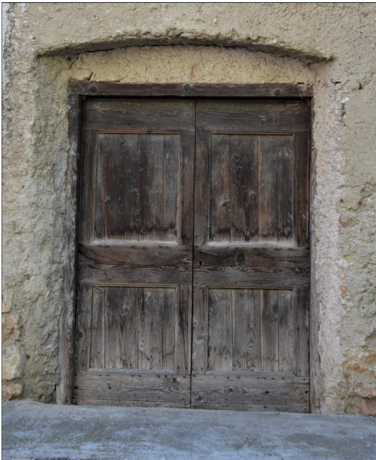
CONTORNI DI PORTE E PORTONI IN MURATURA
