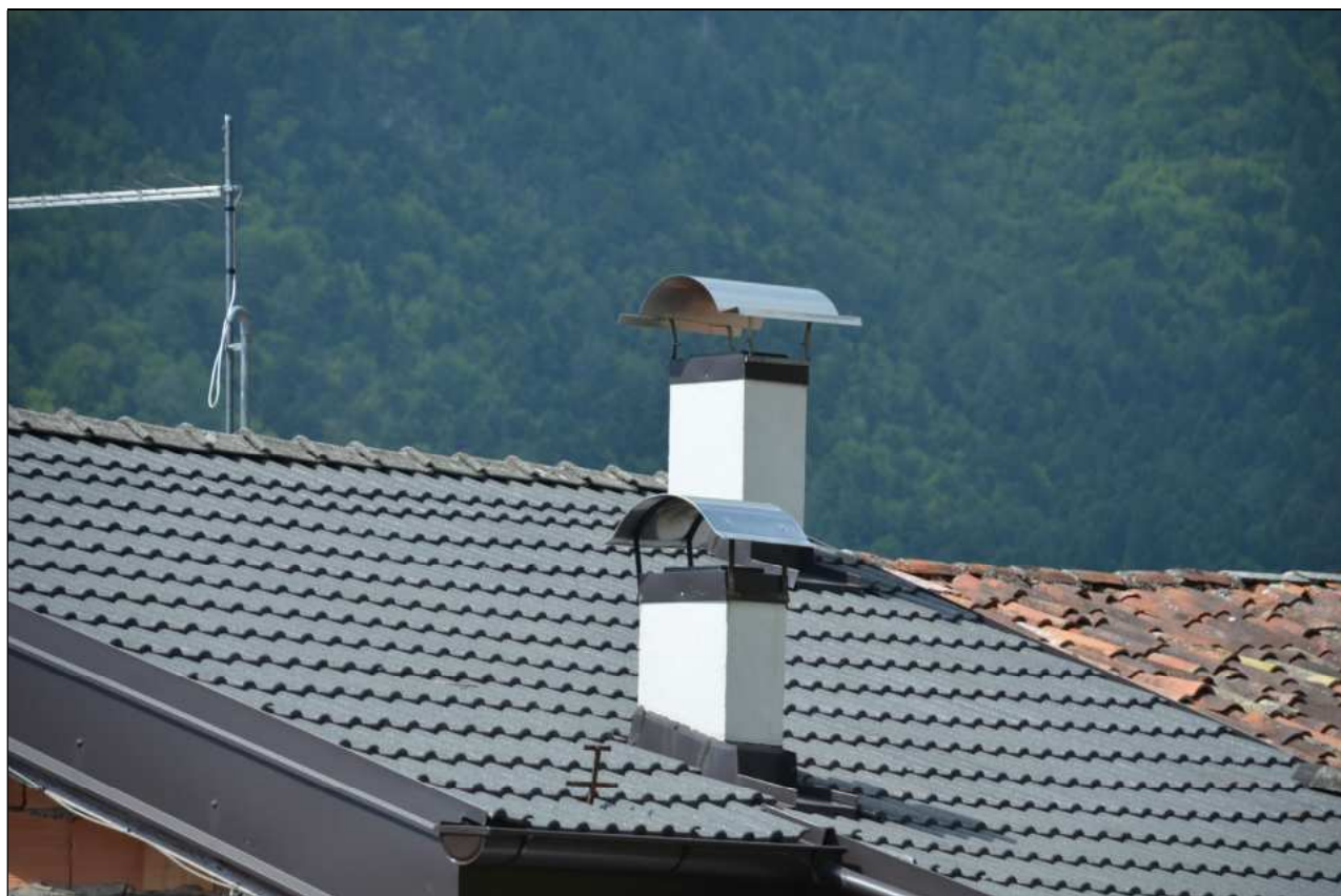
TORRETTE INTONACATE CON CAPPELLI IN LAMIERA
