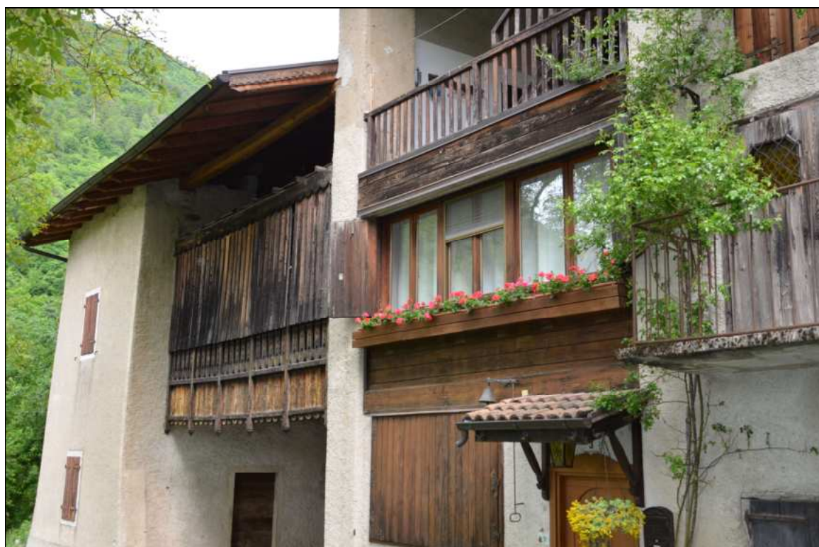
POGGIOLI CON PARAPETTI IN LEGNO A FILETTI O TAVOLE VERTICALI
