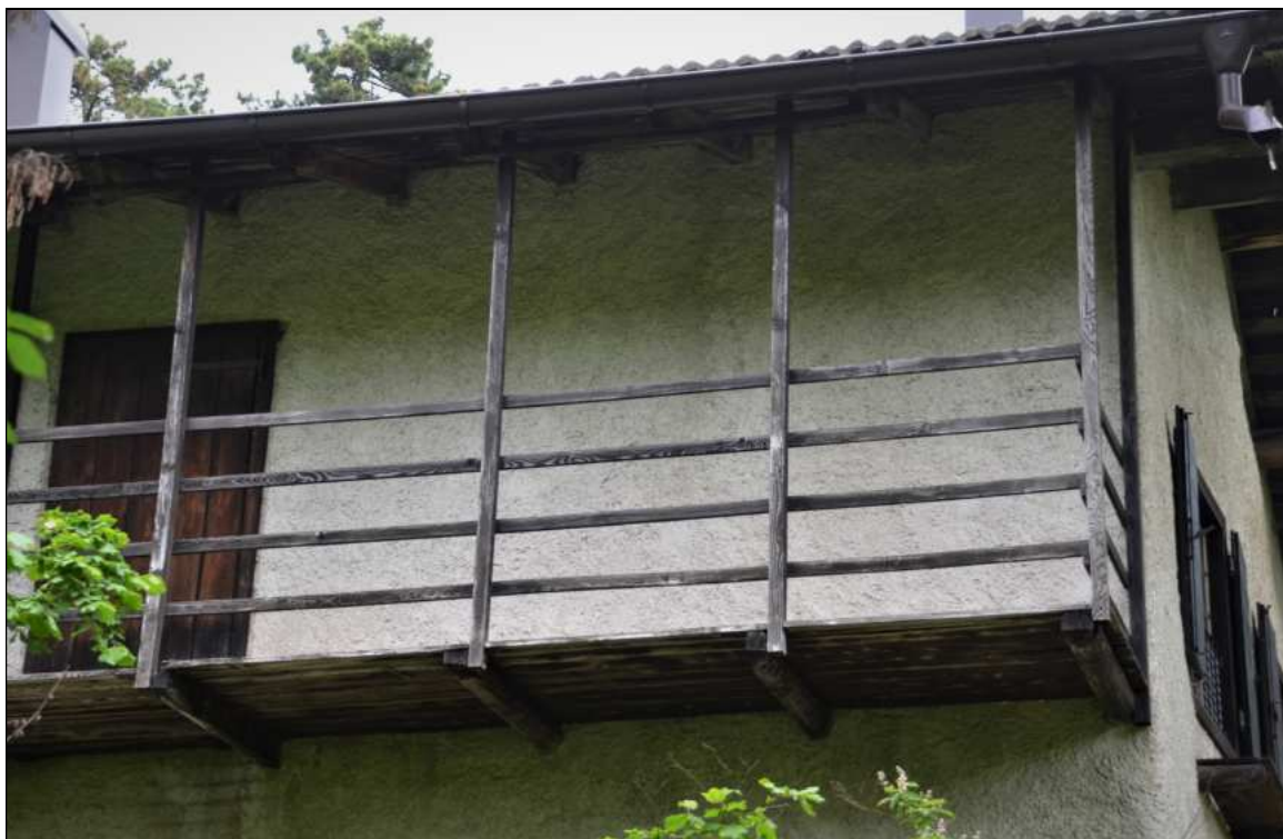
POGGIOLI E BALLATOI CON PARAPETTI IN LEGNO A FILETTI O TAVOLE ORIZZONTALI
