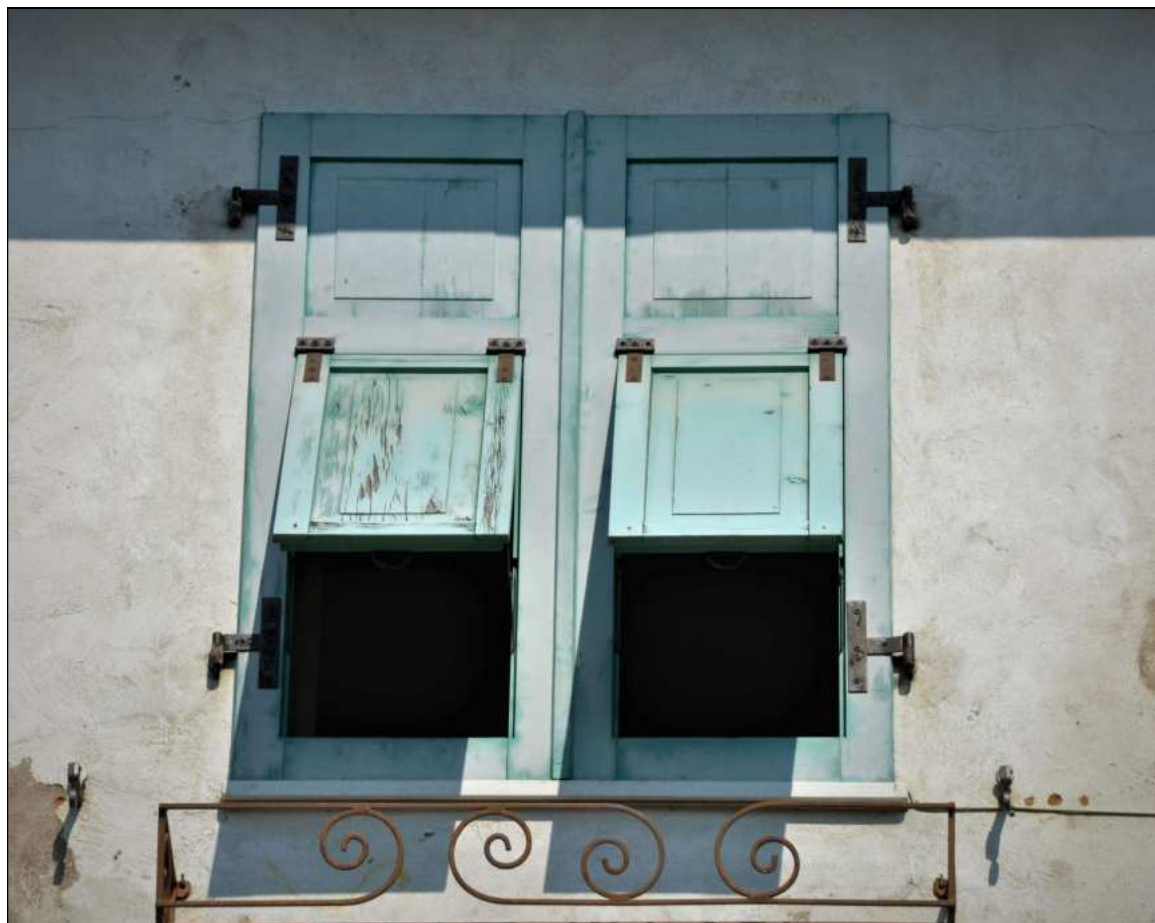
ANTE AD OSCURO CON SPECCHIATURA DOPPIA
